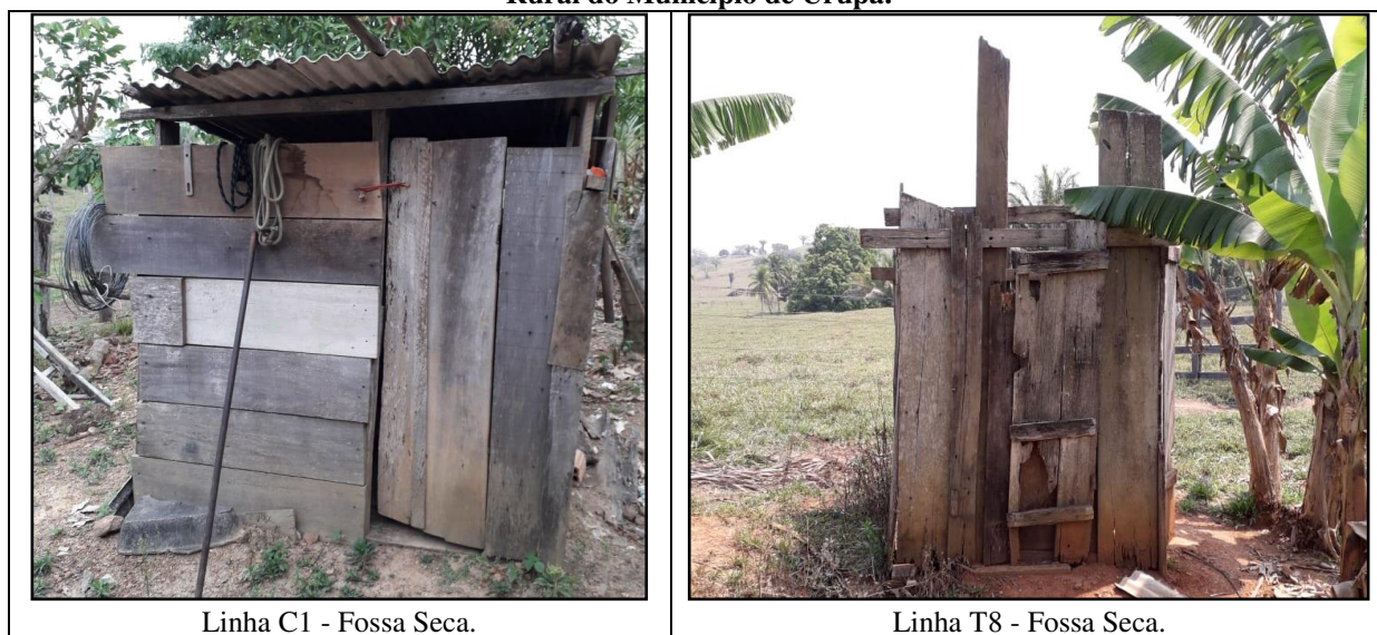
Figura 36—Fossas Secas Utilizadas Como Destinação Final dos Efluentes Domésticos Gerados na Área Rural do Município de Urupá.
