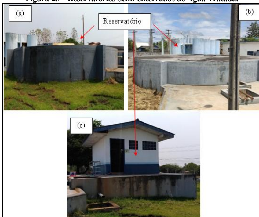
Figura 25—Reservatórios Semi-enterrados de Água Tratada.
