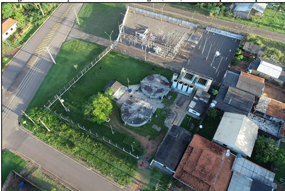
Figura 12—Estação de Tratamento de Água (ETA) do Município de Urupá/RO.
